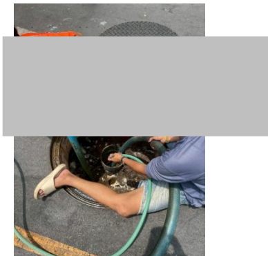
รูปที่ 2-46 การสูบตะกอนของระบบบำบัดน้ำเสีย
